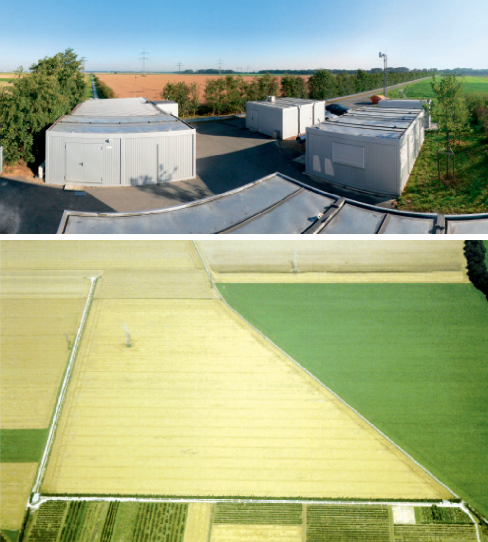
Feldforschung: Das Gelände von GEO600 in Ruthe bei Hannover. In den in Containern untergebrachten Büroräumen und Messvorrichtungen (oben) werten Forscher die Daten aus, die sie in den 600 Meter langen Interferometerarmen gewinnen (unten). Unter einer Schutzabdeckung ist das Vakuumrohr aufgehängt, in dem der Laser zwischen Strahlteiler und Endspiegel verläuft (rechts).
